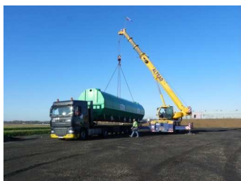
Déchargement de l'appareil
